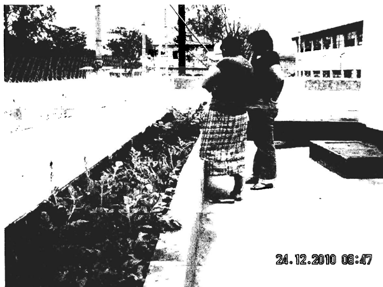
Inspección de las jardineras llenas de hierba
