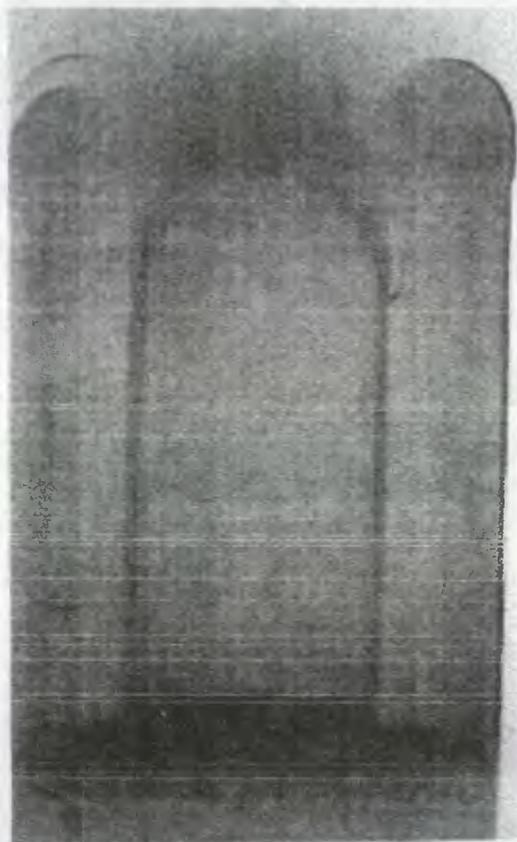
**Foto 23:** Se puede apreciar el tapiado de un arco de medio punto en la parte noroeste del predio vecino del templo. Así también se observa la aplicación de pintura de hule en los muros y techo.
