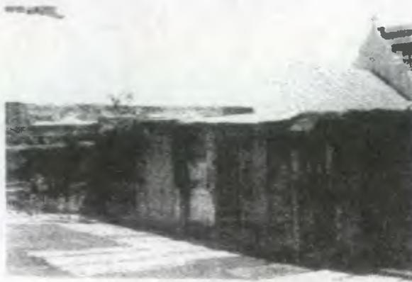
**Foto 9:** Se puede observar que aun quedan vestigios del monasterio de las clarisas en la foto se muestra que han sido tapiados con block y lamina galvanizada los vanos de puertas en el muro que se encuentra aun costado del templo, así también se puede notar el arranque de un arco de mampostería en la parte derecha de la fotografía.
