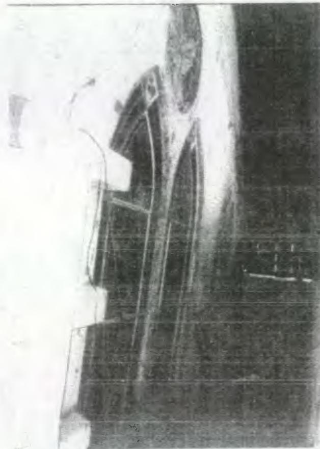
**Foto 32:** Vista del estado de deterioro que presentan los vitrales en la parte oeste del muro donde la lluvia, el viento y el abandono a contribuido a la oxidación y deterioro de los marcos de metal de los vitrales.
