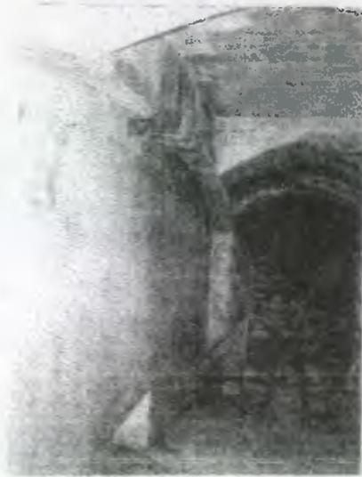
Foto 1: se puede observar el desprendimiento de estuque de los muros y techo de un corredor ubicado al costado de la sacristía del templo.
