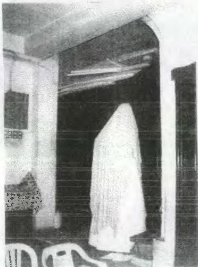
**Foto 37:** Vista de la sacristía donde se puede observar las vigas utilizadas en la construcción del entrapiso del 1er nivel. Y el tapiado de un arco que colinda con la propiedad vecina.
