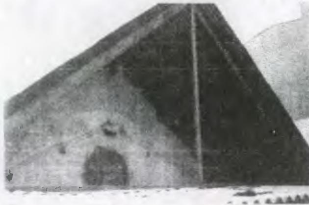
**Foto 5:** Se puede observar la estructura metálica cubierta con lamina de zinc, que se le colocó hace algunos años al templo que contrasta con la tipología constructiva del edificio.
