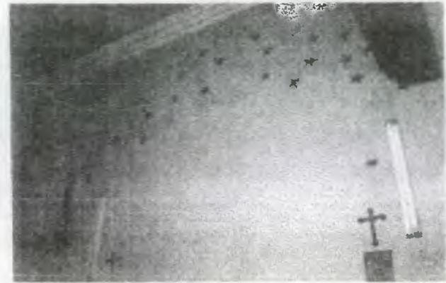
**Foto 15:** Se puede observar que en las paredes internas del templo, les fue aplicada Pintura de hule, lo cual ha contribuido a que el alicado se este abombando ya que este no permite que transpire la humedad del muro, como se aprecia en la fotografía.
