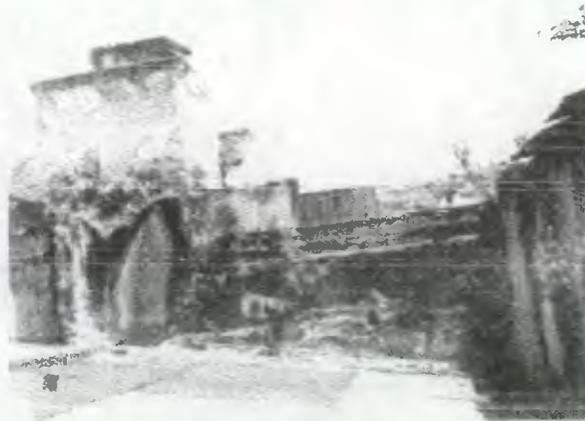
**Foto 10:** Se puede observar el deterioro que presenta el muro y contrafuerte norte del templo donde se evidencia la falta de mantenimiento, con la aparición de vegetación en los muros así como también cuarteaduras y grietas en el contrafuerte y muro. En la parte inferior de la fotografía se puede apreciar los vestigios de una pechina de mampostería.
